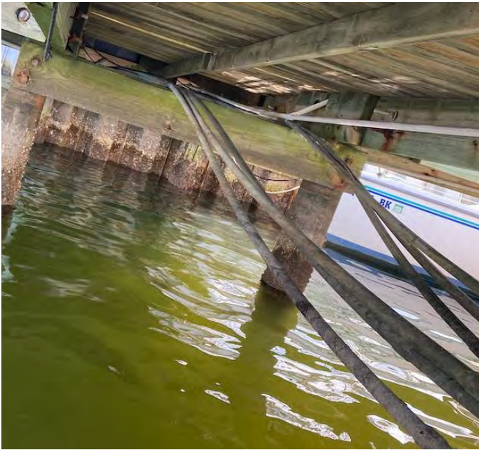
Cracked electrical conduit.
